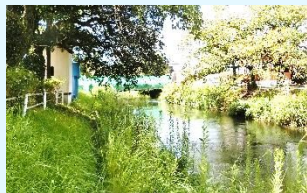
上流部 (3) 植木水位観測所付近
