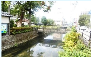
下流部 (7) 北御門跡付近
