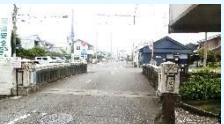
③⑨ 開運橋 1935.5竣工 佐賀城下の多布施町と 岸川間に架かる橋
