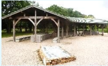
20 多布施川河畔公園東屋 多布施川の生き物紹介パネルが設置
