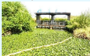
最下流部 (3) 大崎樋門
