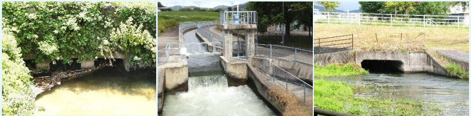
⑪石井樋(多布施川取水口)
