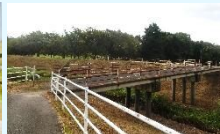
33 石井樋橋1979.9竣工 最上流に架かる橋
