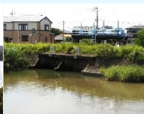
㉙ 大崎樋門
