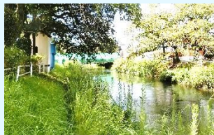
上流部 (3) 植木水位観測所付近
