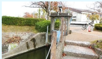
②⑩南濠井樋（自然排水）
