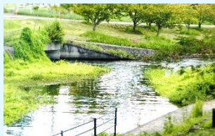
上流部 (14) 幹線水路からの取水口付近
