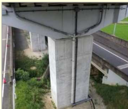
橋脚補強（コンクリート巻立）
