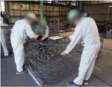
【現地状況（特殊部配筋）】
