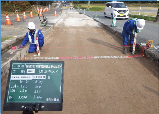
【立会状況（現場側）】
