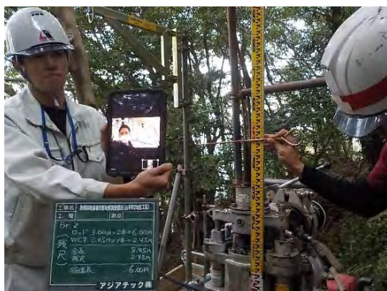
【立会状況（現場側）】
