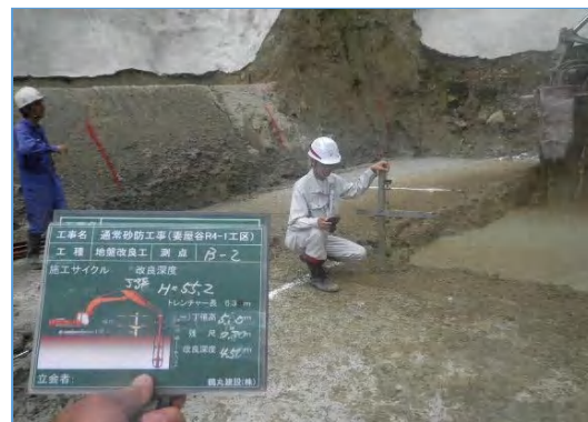
【出来形管理（杭ナビ測量）】
