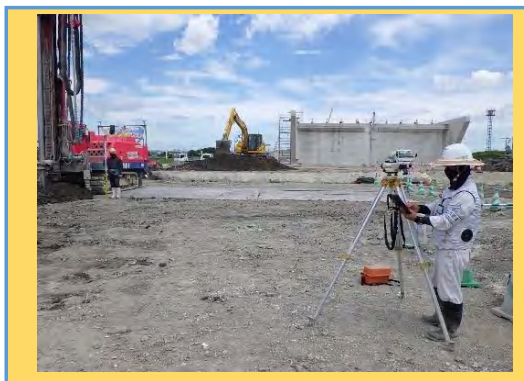
【立会状況（現場側）】
