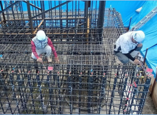
【立会状況（現場側）】
