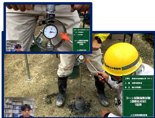
【立会状況（現場側）】
