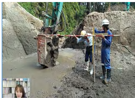
【地盤改良立会状況（現場側）】
