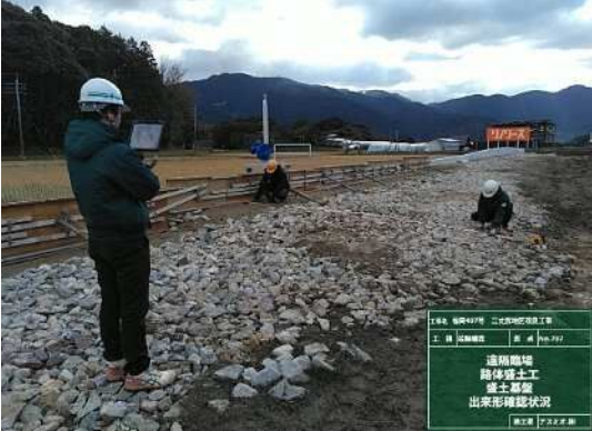
【立会状況（現場側）】
