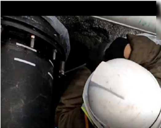
【立会状況（現場側） 締付トルク確認】
