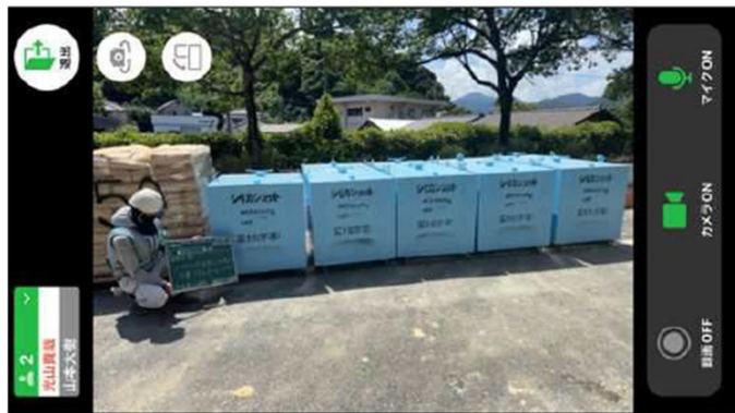
【立会状況（現場側） 地盤改良材確認】
