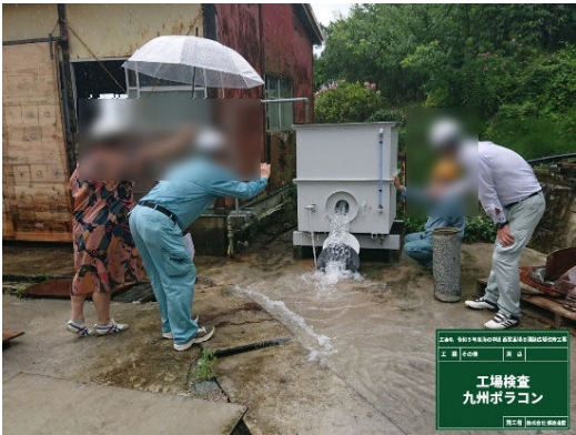
【立会状況（現場側）】
