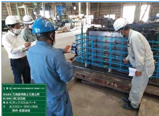
【立会状況（現場側）】
