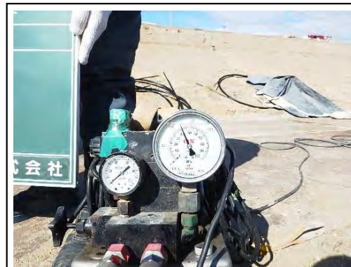
【緊張力を確認（現場側）】
