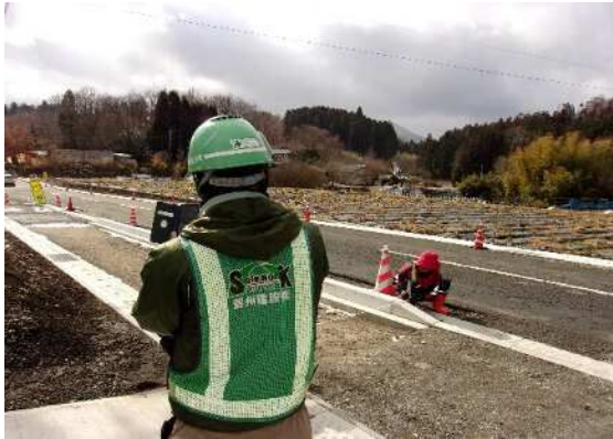
【立会状況（現場側）】
