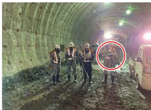
【会議用スピーカーの設置（現場側）】
