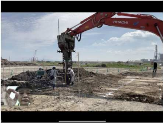
【立会状況（現場側）地盤改良工】
