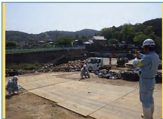
【立会状況 (現場側)】
