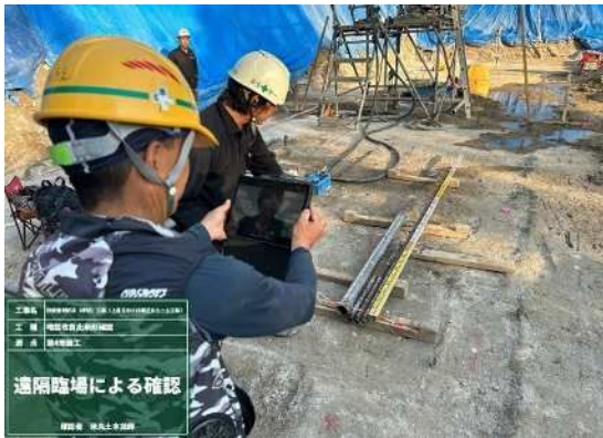
【立会状況（現場側）】
