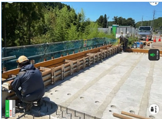
【立会状況（地覆型枠検測）】
