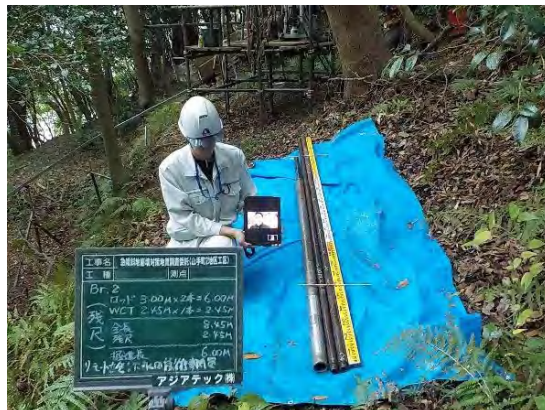
【立会状況（現場側）】
