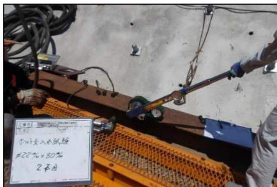
【現場確認状況（トルクレンチ確認）】
