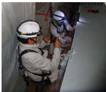
【測定箇所に照明を設置】
