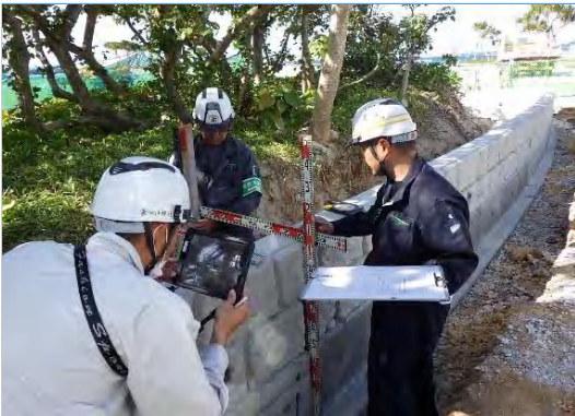
【立会状況（現場側）】
