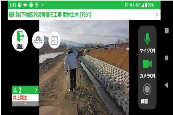
【立会状況（現場側）】
