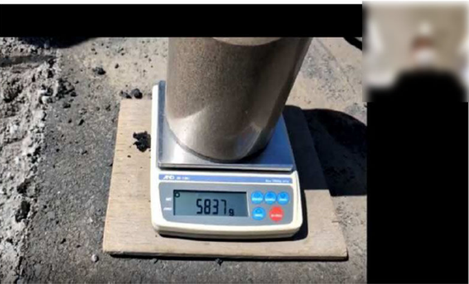
【立会状況（現場側） 路盤密度試験状況確認】
