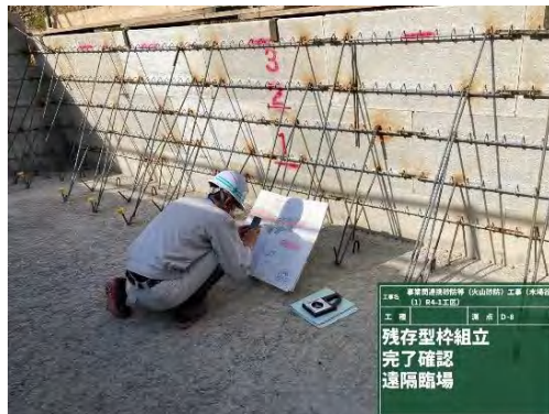
【立会状況（現場側）】
