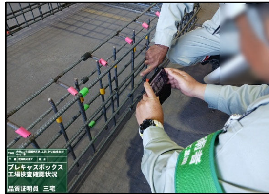
【鉄筋マーカーによる表示】
