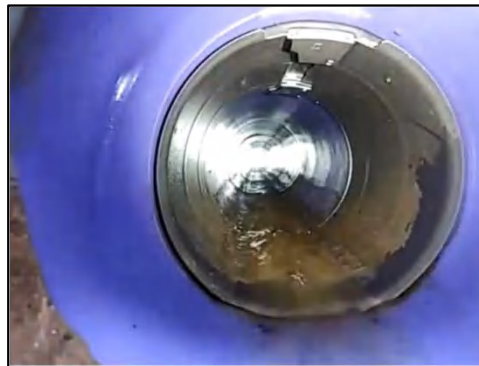
【オンライン検査（管の通り確認）】
