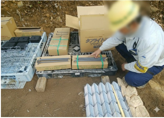
【立会状況（現場側）】
