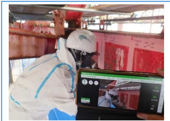
【立会状況（現場側）】
