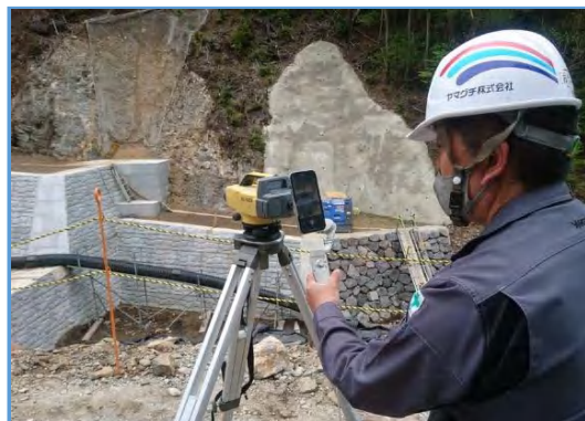
【立会状況（現場側）】
