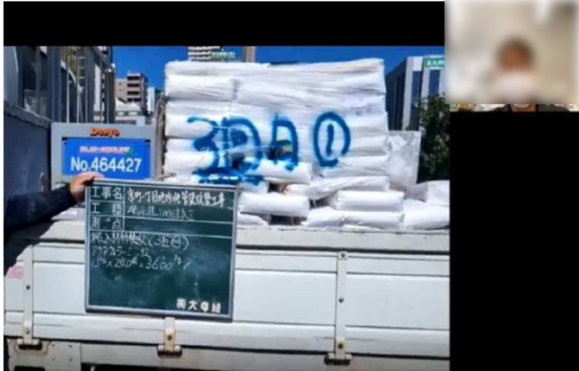
【立会状況（現場側） 材料確認状況(保水性舗装材料)】
