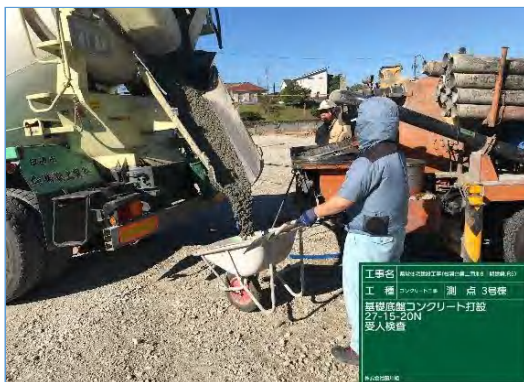
【立会状況（現場側）】
