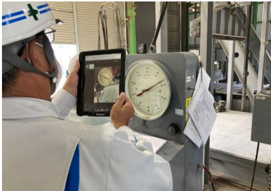
【現場側の使用機器】
