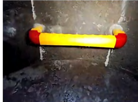
【オンライン検査（足掛金物取付確認）】
