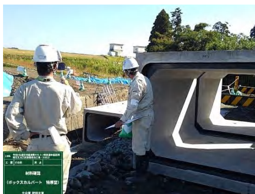
【立会状況（現場側）】
