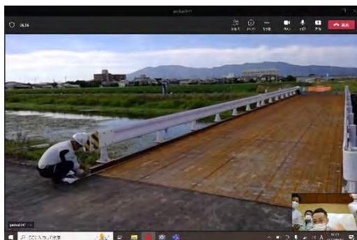
【立会状況(現場側)】
