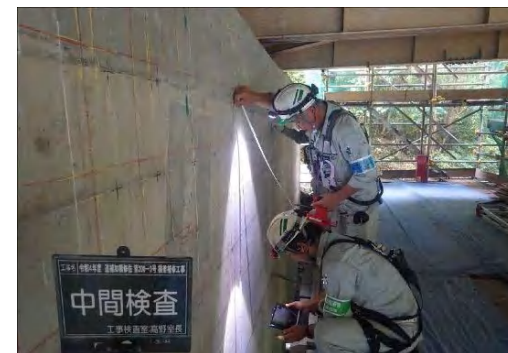
【立会状況（現場側）】
