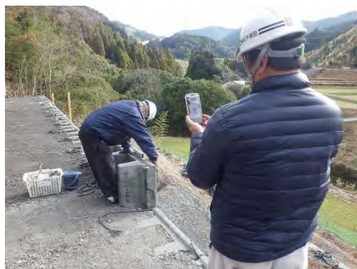
【立会状況（現場側）】
