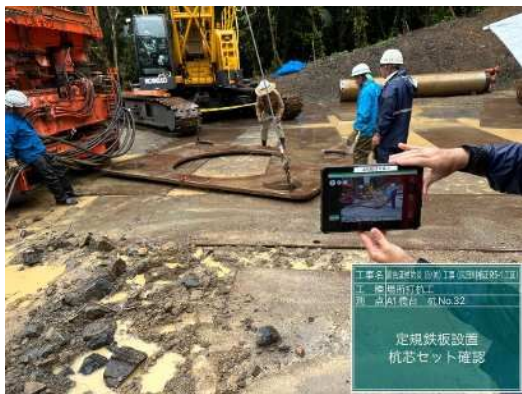
【立会状況（現場側）】
