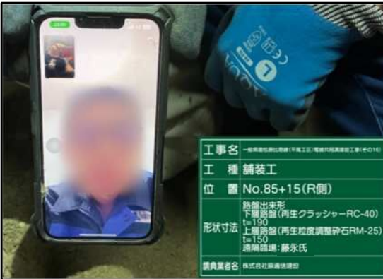
【立会状況（路盤出来形確認）】
