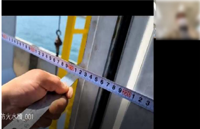
【近景撮影状況(防火水槽材料確認)】
