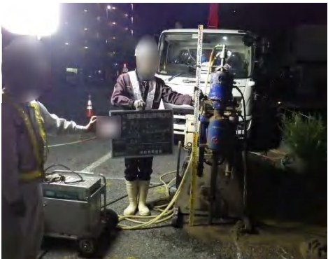
【現地状況（薬液注入ロット検尺）】
