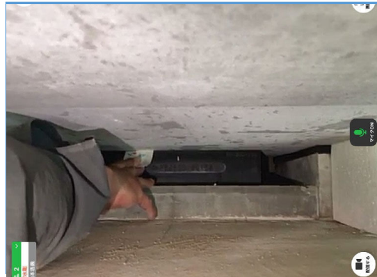
【立会状況（足場解体前支承部確認）】
