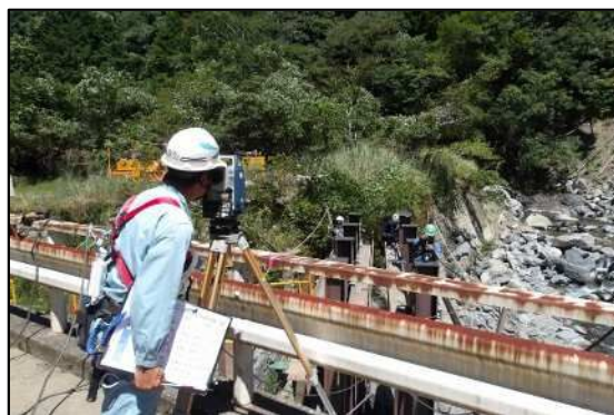
【現場確認状況（支持杭確認）】
