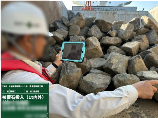
【立会状況（現場側2）】
