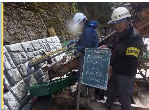
【立会状況(施工状況)】
