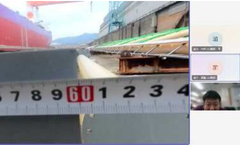
【出来形確認状況（近景）】
