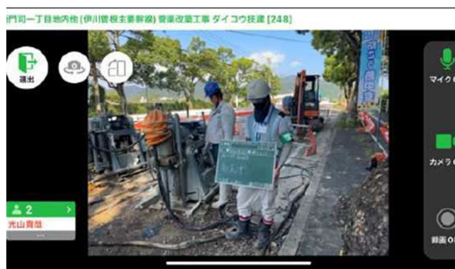
【全体状況,細部状況確認】
