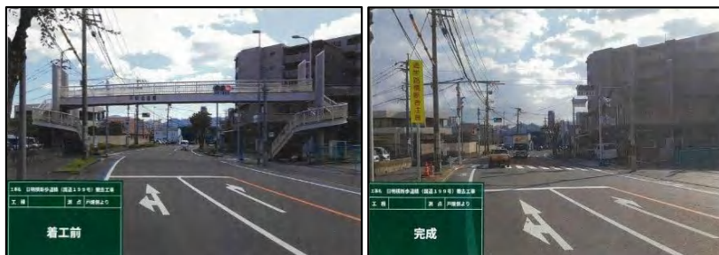
【着工前・完成】
