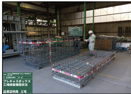
【立会状況（現場側）】
