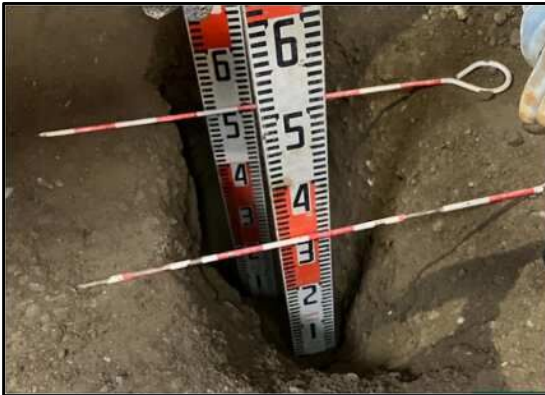
【立会状況（路盤出来形確認）】
