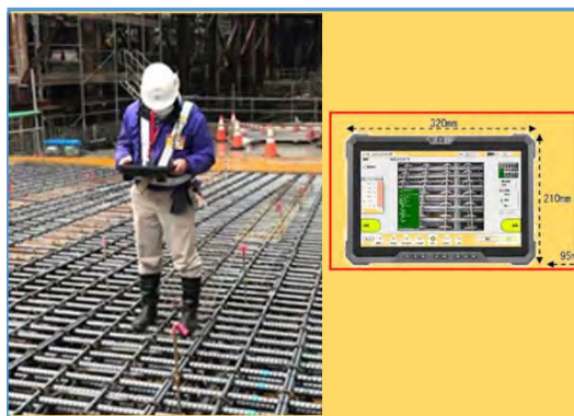
【立会状況（現場側イメージ）】
