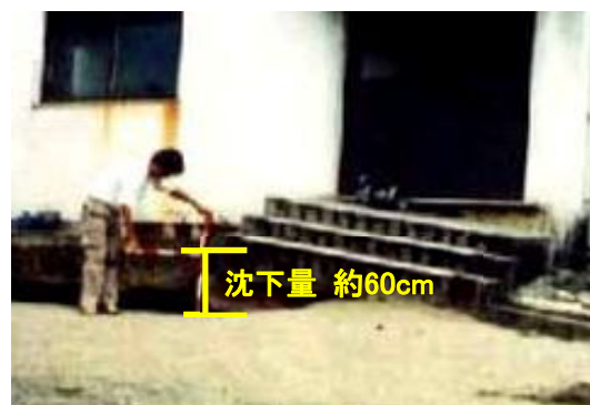
写真 2.2.7 白石町での地盤沈下状況
