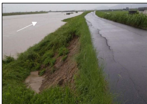
写真 1.2.1 堤防の法崩れの様子
