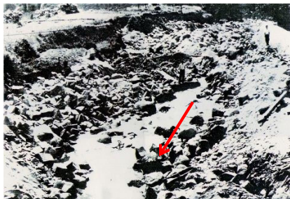
↑ 貝野地区の土石流による河岸の崩壊
