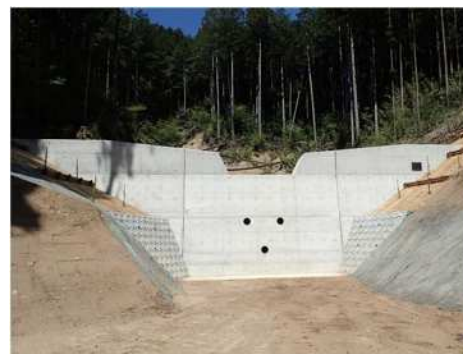
工事完了（溪間工事）
