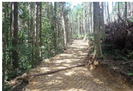
森林作業道の作設
