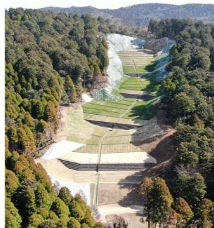
工事完了（山腹工事）
