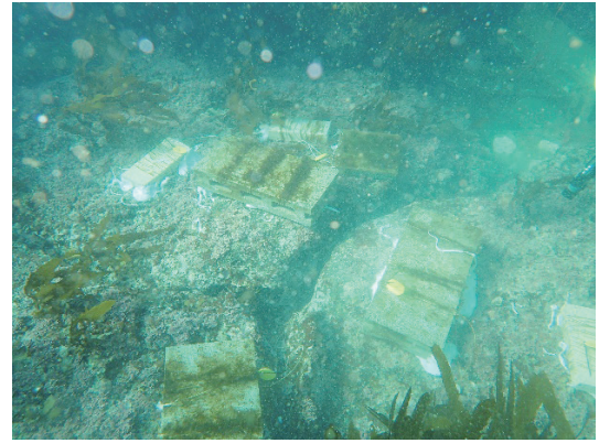
写真5 天然藻場造成試験のブロック設置の様子
