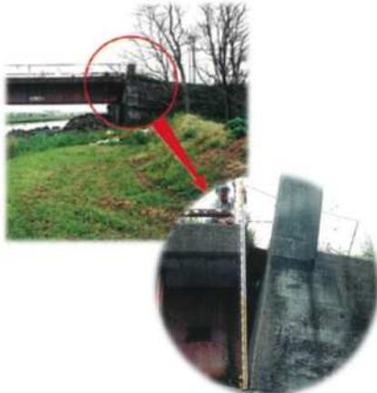
地盤沈下により危険な状態になった橋
