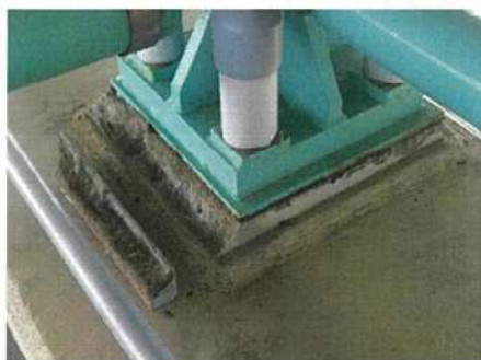
野球場支柱劣化
