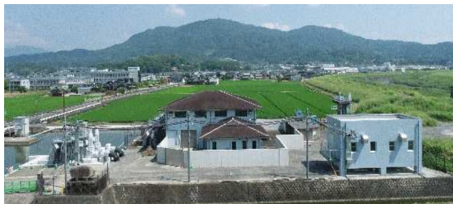
下潟排水機場の全景
