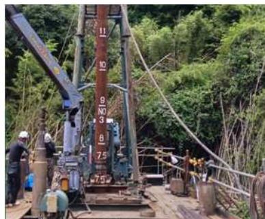
抑止杭工の施工状況 (有田町)
