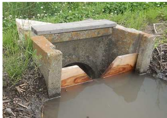
田んぼダムの調整板の設置
