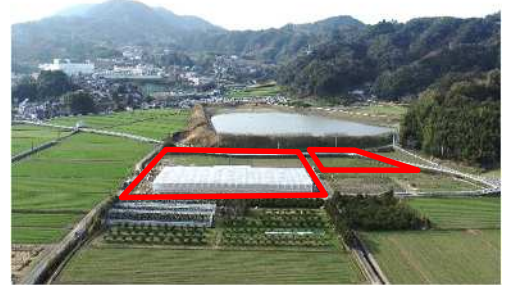
園芸団地（江北町門前第2地区）
