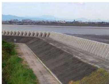
嵩上げされた海岸堤防 (佐賀市)
