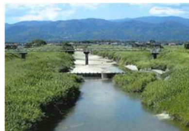
統廃合により撤去される頭首工 (吉野ヶ里町)
