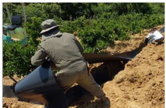
シールディング・マルチの設置
