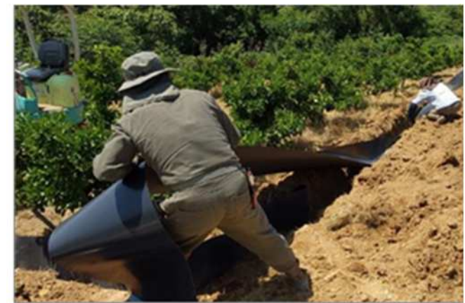
シールディング・マルチの設置
