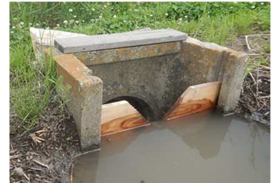
田んぼダムの調整板の設置
