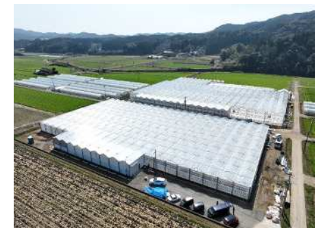
整備が完了した園芸団地 (武雄市西梅野地区)
