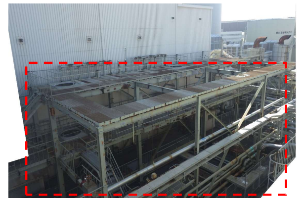
【玄海1号機 脱気器の解体撤去の状況】
