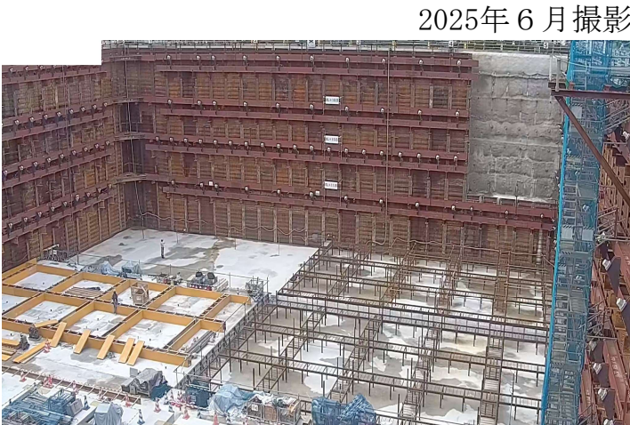
工事状況 (建屋設置工事)
