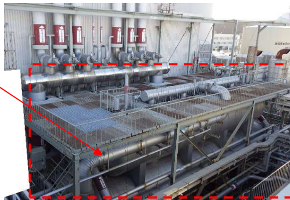
【玄海1号機 脱気器の解体撤去の状況】
