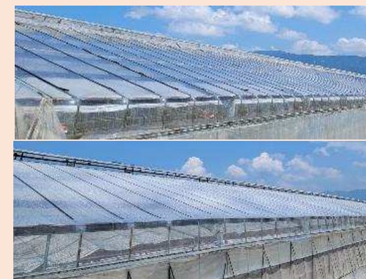
遮熱塗布剤 (上:塗布前、下:塗布後)
