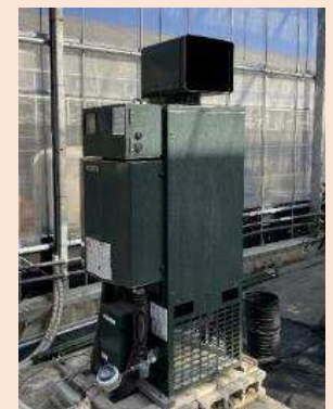
光合成促進機 (炭酸ガス施用機)
