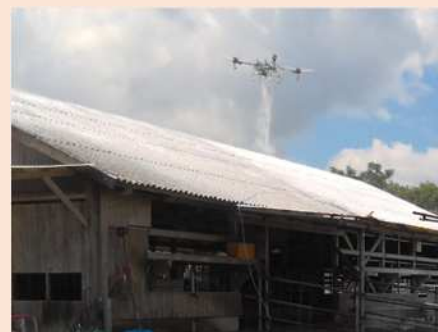
ドローンによる畜舎屋根への消石灰塗布
