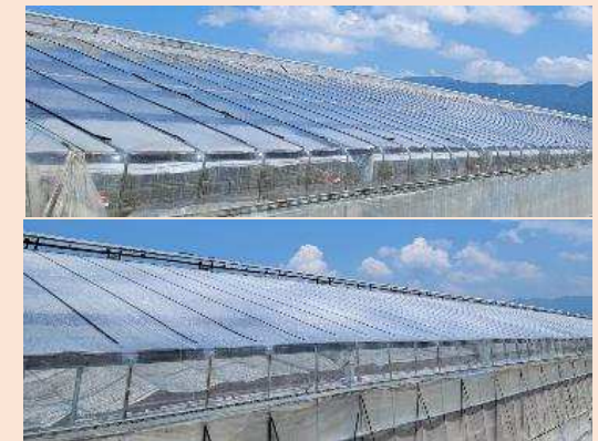
遮熱塗布剤（上：塗布前、下：塗布後）
