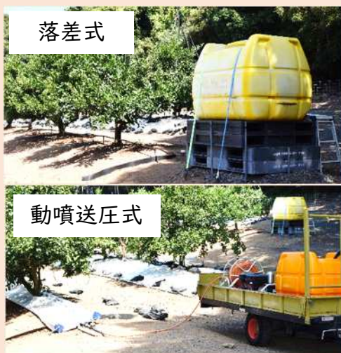
簡易かん水設備
