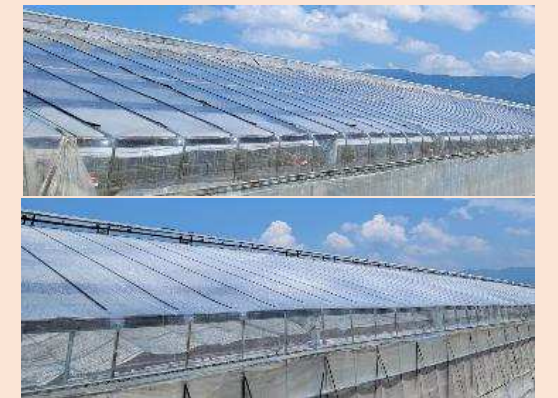
遮熱塗布剤（上：塗布前、下：塗布後）
