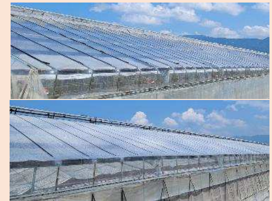
遮熱塗布剤 (上：塗布前、下：塗布後)
