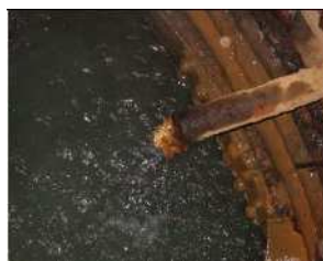
② 1号集水井鋼材腐食近景
