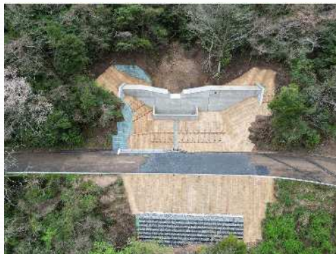
○整備後（R4武雄市 赤穂山地区）
