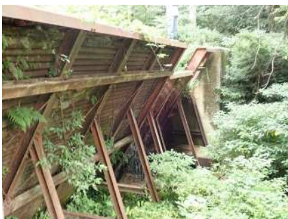
① 既設ダム状況 (S58施工)
