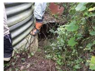
③ 1号集水井地盤陥没状況
