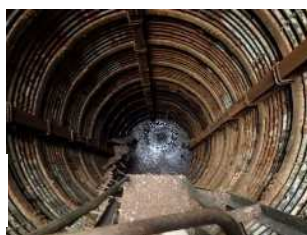
② 1号集水井鋼材腐食近景
