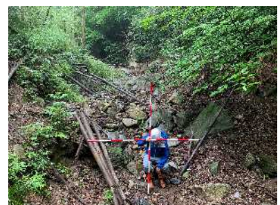
③不安定土石堆積狀況
