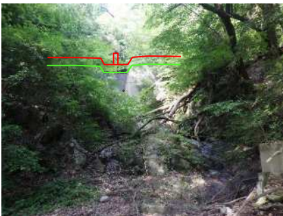
①流末及び既設治山ダム状況
