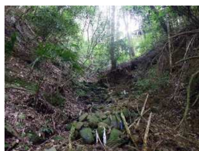
③ 不安定土石堆積狀況
