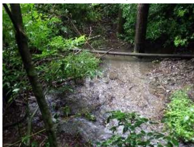
① 流末状況荒廃状況 (流路工計画位置)
