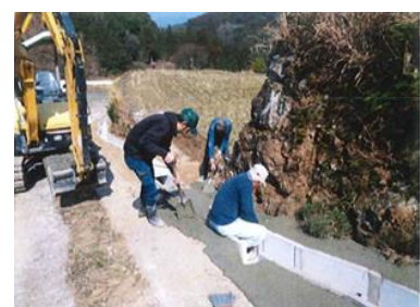
【地域住民による農道補修】
