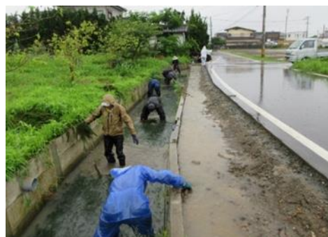
【水路内の泥上げ】
