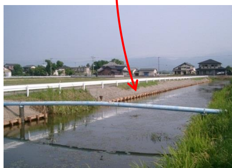
【木柵工による護岸整備】
