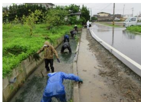
【水路内の泥上げ】
