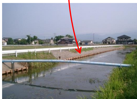
【木柵工による護岸整備】
