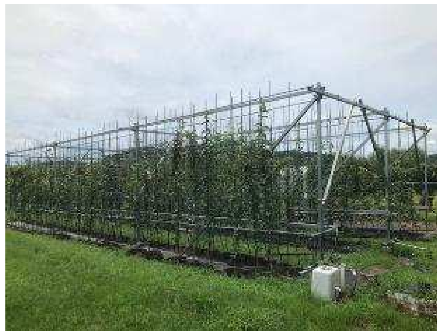
図2 解体する大苗育苗施設
