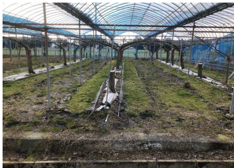
写真 現在の工事位置②の状況
