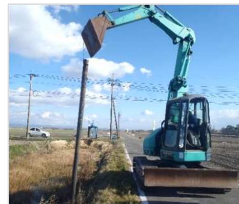
クリーク杭引抜状況
