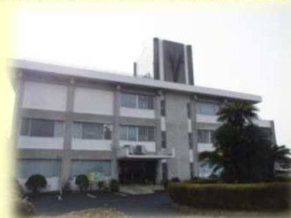
林業試験場庁舎(昭和53年(1978年)竣工)
