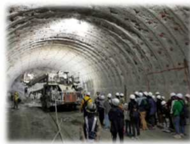
【施工中のトンネルの現場を見学】
