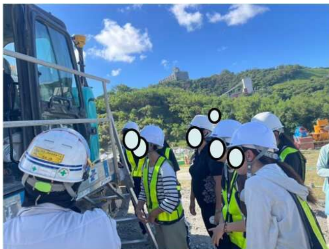
工事現場でICT建機の見学
