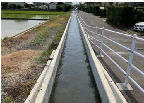
改修された用水施設
