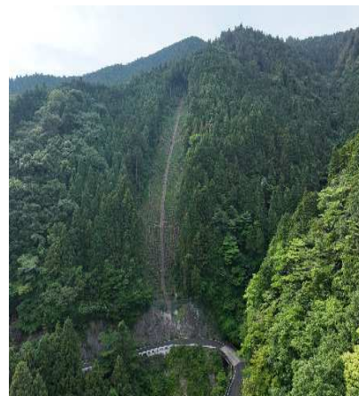
工事完了（山腹工事）
