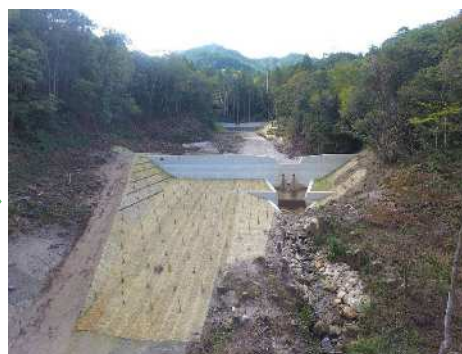
工事完了（溪間工事）
