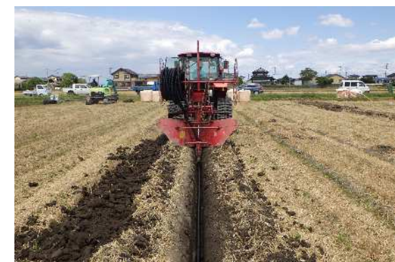
暗渠排水の整備
