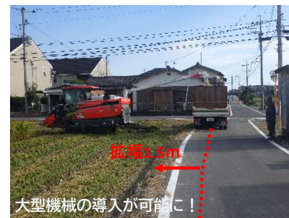
農道拡幅工事
