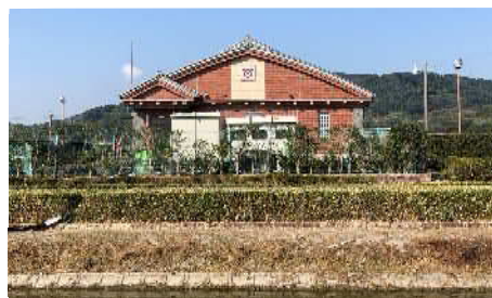
農業集落排水処理場
