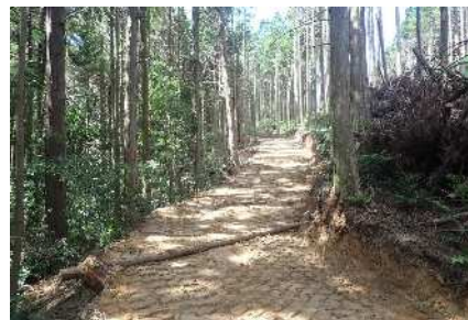
森林作業道の作設
