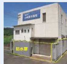
▶ 排水機場機能向上
