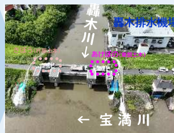
▶ 排水ポンプ車の活用
