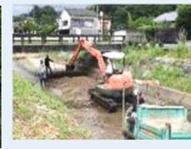
▶ 河川浚渫・伐採
