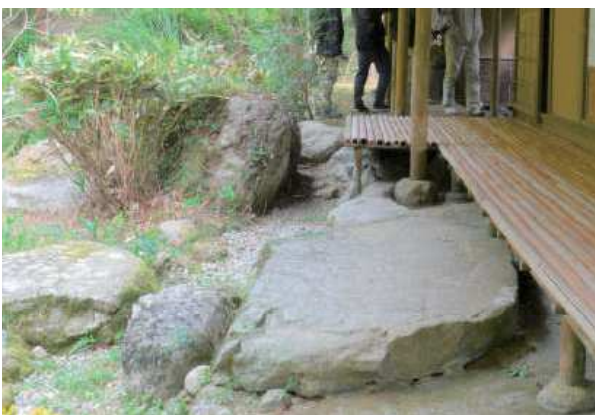
図3-4-16 A 沓脱石 【エ）池周り地区】
