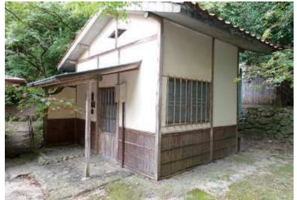
図3-4-29 B ボイラー室 【キ）主屋北地区】
