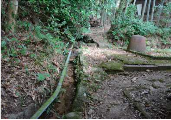
図3-4-26 A 水路 【キ）主屋北地区】
