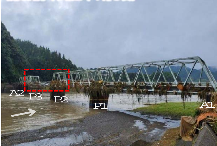
被災状況 (令和2年7月5日)
