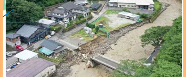
国道219号の被災
