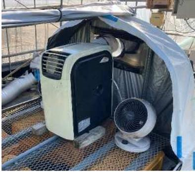
図1 冷風機（左）と循環扇（右）の設置状況
