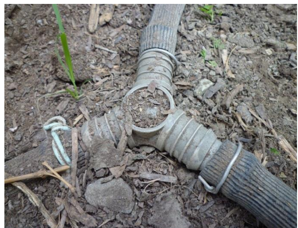
図3 図2の接続部を掘り起こした写真
