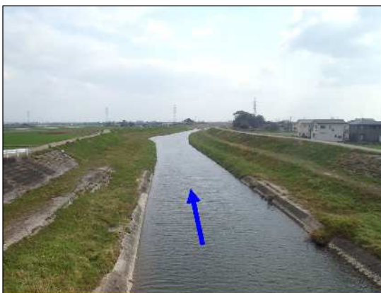
<1号橋下流区間>
