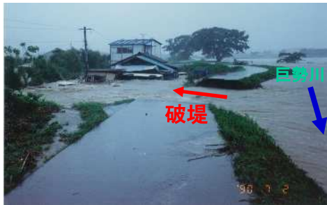
【巨勢川上流破堤状況】
