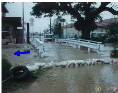
【巨勢川越水状況(学校橋)】
