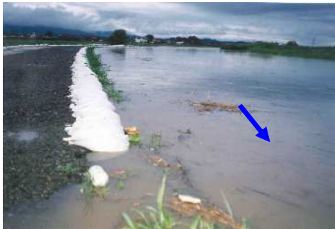
(国道264号より上流)
