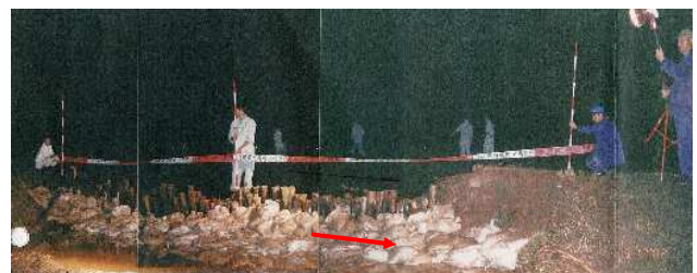
切通川 決壊状況
