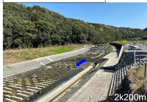
改修後(新山下頭首工)
