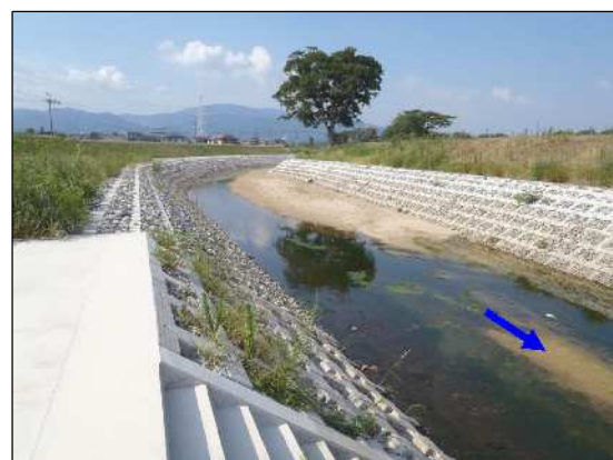
<土井手堰上流区間>
