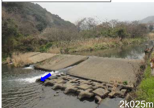
改修前(旧山下頭首工)
