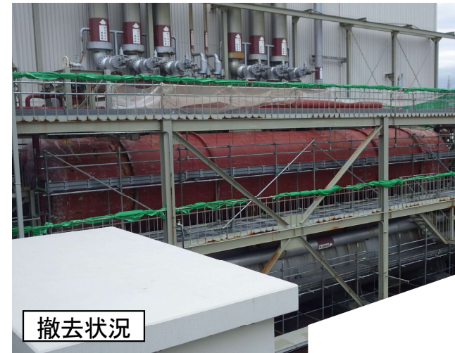
脱気器／湿分分離器逃し弁
