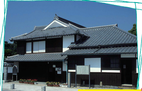
見所MEMO 東面入母屋造妻入り、南も入母屋造となっている。屋根は全て土唐瓦である。
