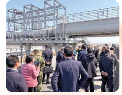
海水混合施設（国造瀬） 海水混合施設に係る施設概要等について
