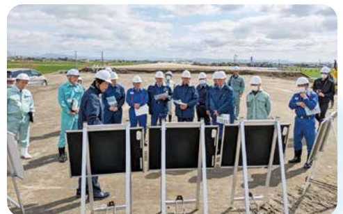
国道208号有明海沿岸道路大川佐賀道路 諸富IC付近～(仮称)川副IC付近 道路工事の進捗状況
