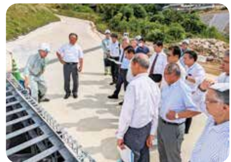
今坂川第三砂防堰堤工事現場 (今坂川第三砂防堰堤工事の進捗状況について)
