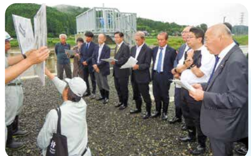
松浦川皿堰 河川整備交付金事業に係る 松浦川皿堰の改築工事の状況
