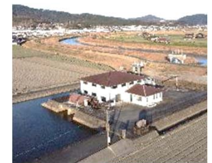
(下瀉排水機場)
