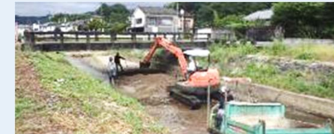
▶ 河川浚渫・伐採
