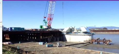
【国事業】大川佐賀道路 (仮)早津江川橋施工状況
