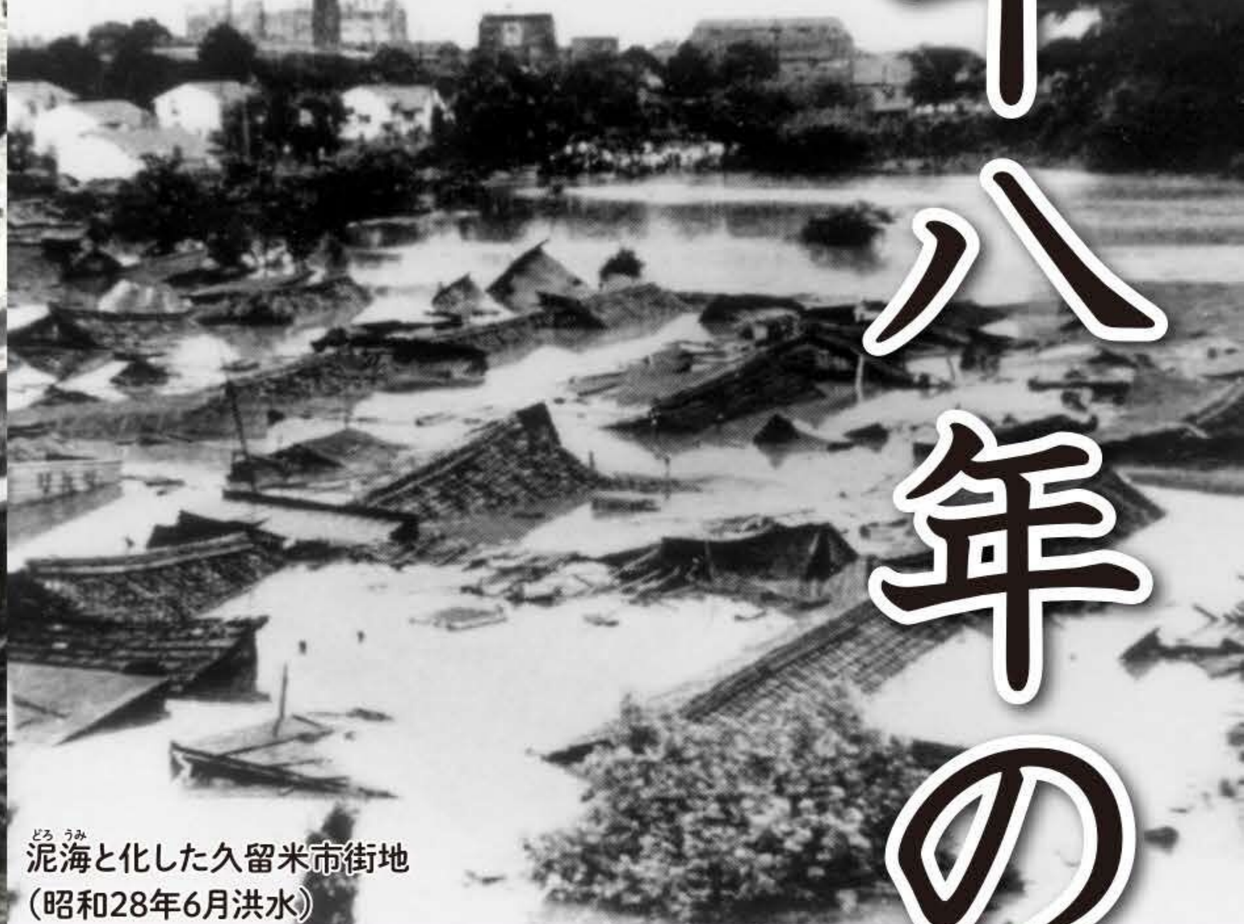
水没した久留米市街地 (久留米医大付近:昭和28年6月洪水)
