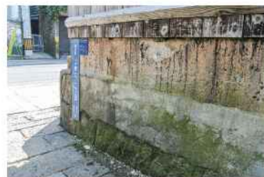
基礎の高さが一目でわかります
