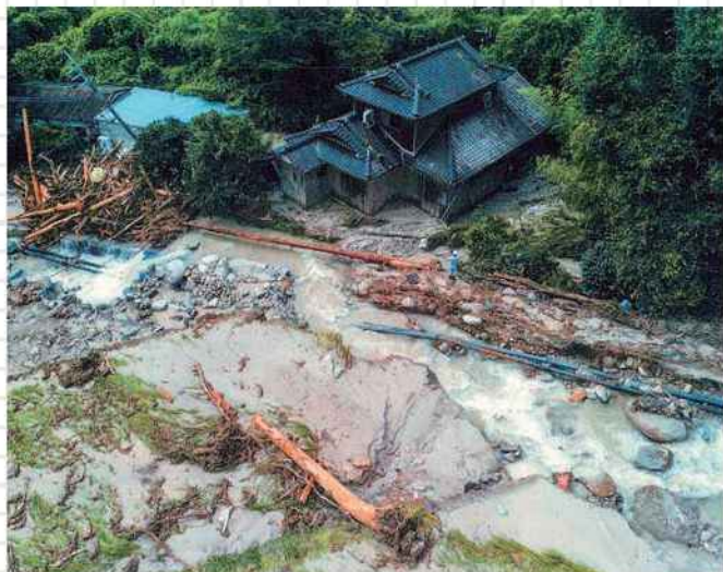
佐賀市（金立の土砂災害）
