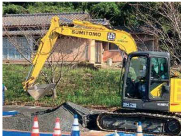
道路啓開訓練 (建設業協会による土砂撤去の様子) (於：肥前総合運動場 北側駐車場)
