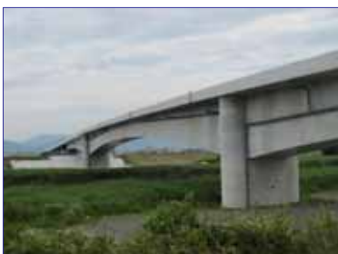
嘉瀬川に架かる橋梁 橋長 280m,最大支間長 121m
