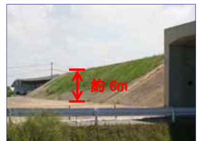
一般(盛土)区間の盛土工事 盛土高 約6m
