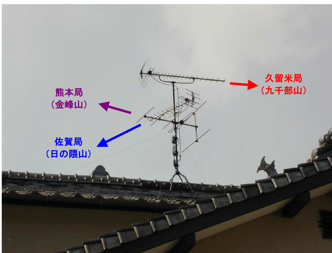
図 2-3. 複数本のアンテナによる受信
