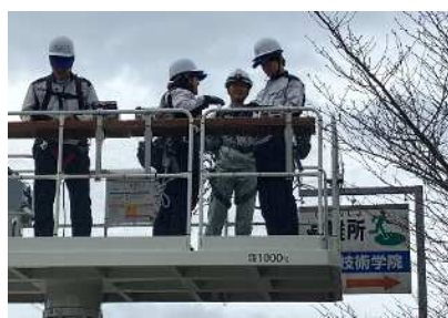
高所作業車での作業
