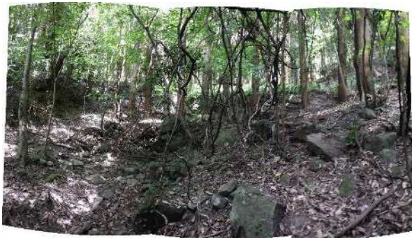
①不安定土石堆積状況
