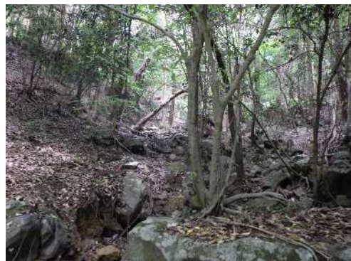
②溪岸侵食及び不安定土石堆積状況
