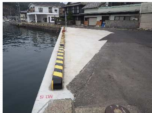
整備後 (星賀港 星賀2号物揚場)
