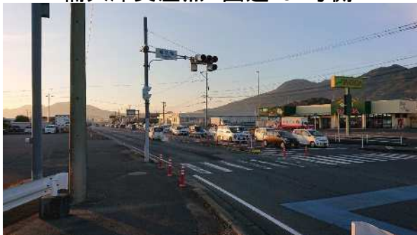
楠久津交差点 国道204号側
