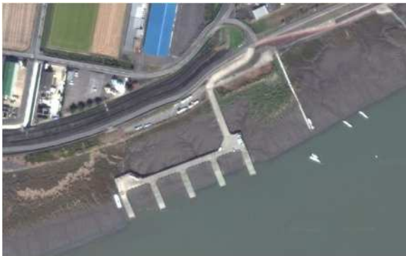
物揚場及び臨港道路の現状
