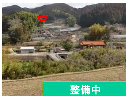
砂防堰堤工(遠景)
