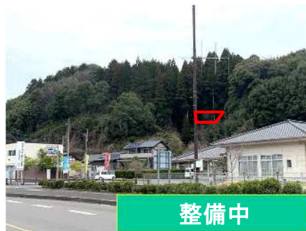
砂防堰堤工(遠景)
