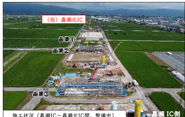
施工状況 (嘉瀬IC～(仮)嘉瀬北IC間。整備中)
