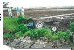
法面の崩落状況 (トラクターの転落)
