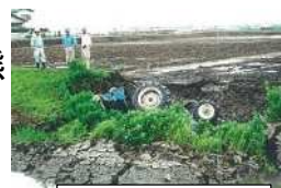
法面の崩落状況 (トラクターの転落)
