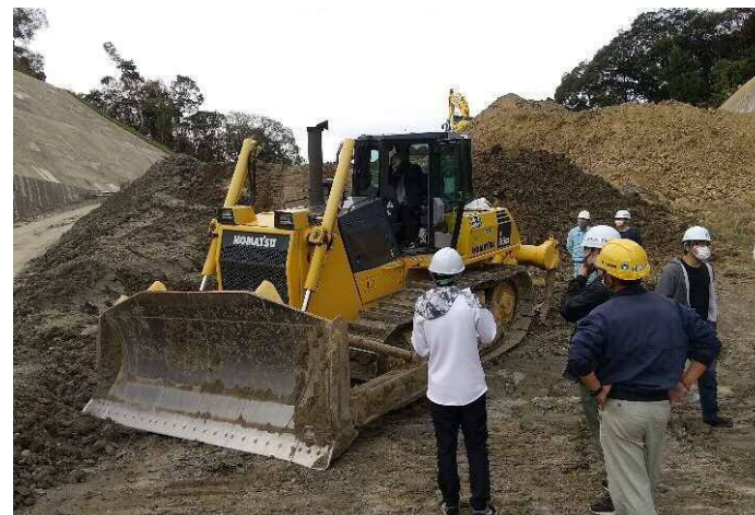
■県道宮崎西環状線 道路工事 ICTブルドーザ
