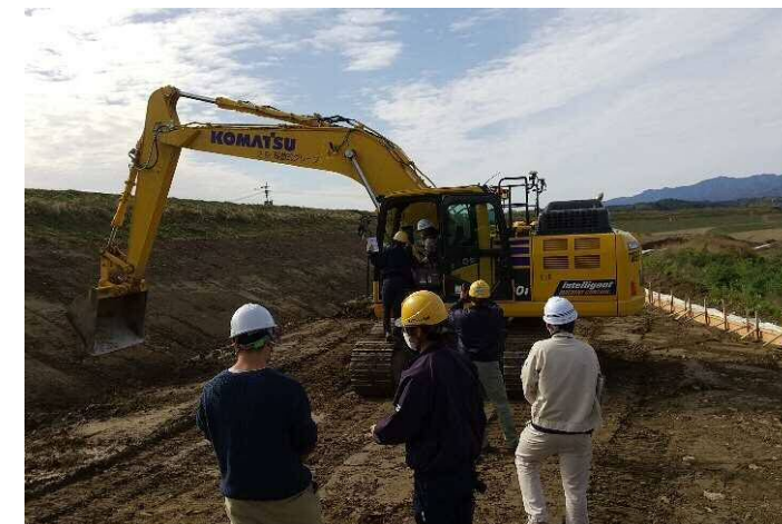
■三財川 河川工事 ICTバックホウ
