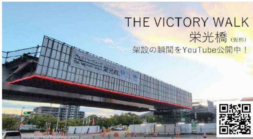
SAGA サンライズパーク栄光橋仮設工事
