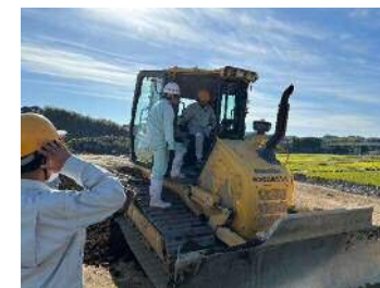
【河川土砂掘削・県体育館建設 防災ステーション造成工事現場】
