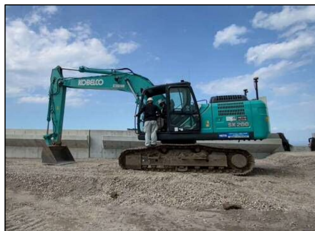
■ ICT建機の操作体験
